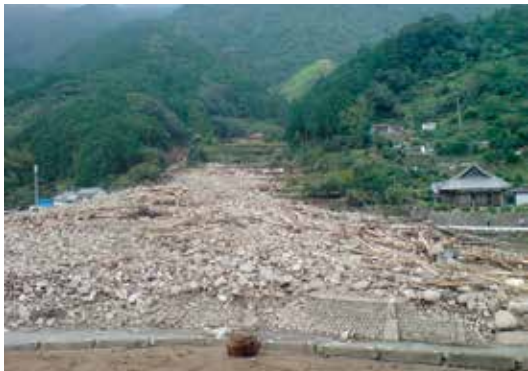
那智勝浦町市野々地区（土石流）
