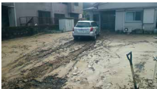
厚さ約20cmの汚泥が堆積（汚泥は水を含み粘土質のものであった）
